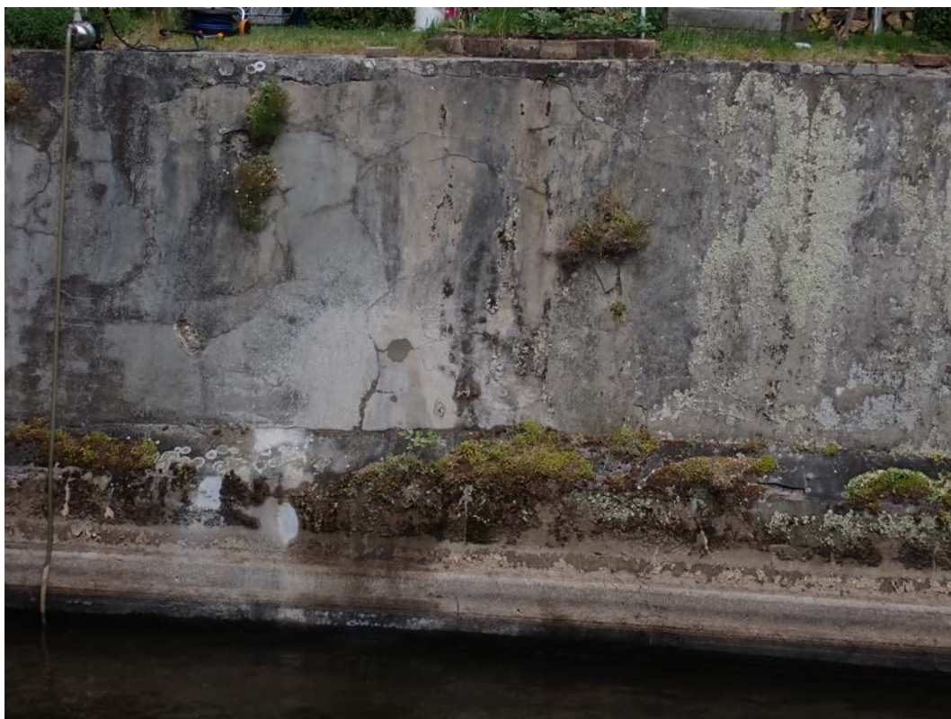
Foto 5: Část 3: Zed' je opatřena cementovým torkretem, v torkretu síť trhlin 2 až 5 mm. Povrch betonu degradují rostliny, mechy a lišejníky.
