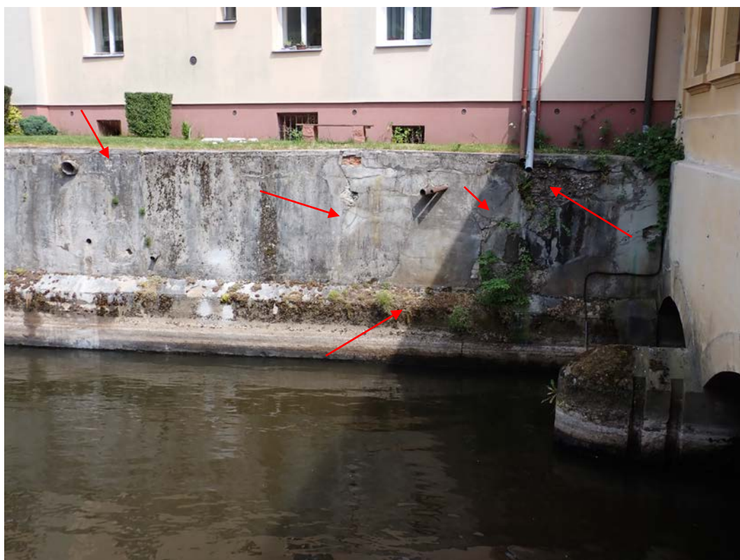
Foto 3: Část 1: Degradace betonu do hloubky 10 až 15 cm, trhliny ve zdivu šíře 5 až 10 mm, zeď je opatřena cementovým torkretem, v torkretu síť trhlín 2 až 5 mm. Povrch betonu degradují rostliny, mechy a lišejníky.
