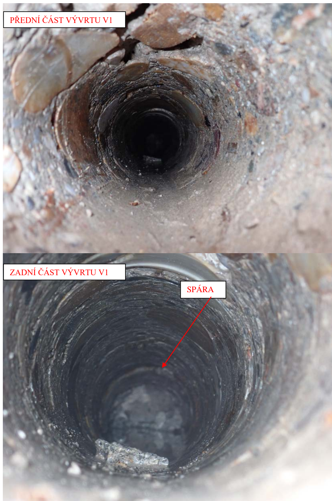
Vývrt V1 pro zjištění skladby a rozměrů PB
