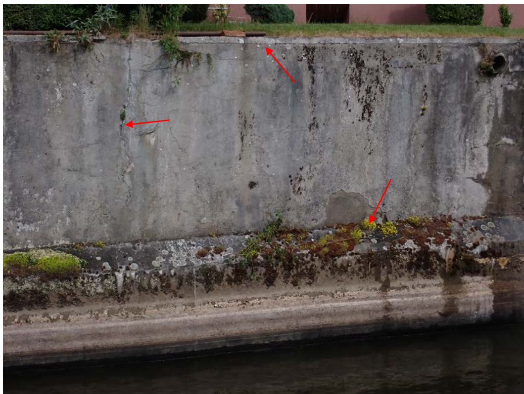
Foto 4: Část 2: Trhlina ve zdivu šíře 5 až 10 mm, zeď je opatřena cementovým torkretem, v torkretu síť trhlín 2 až 5 mm. Povrch betonu degradují rostliny, mechy a lišejníky.
