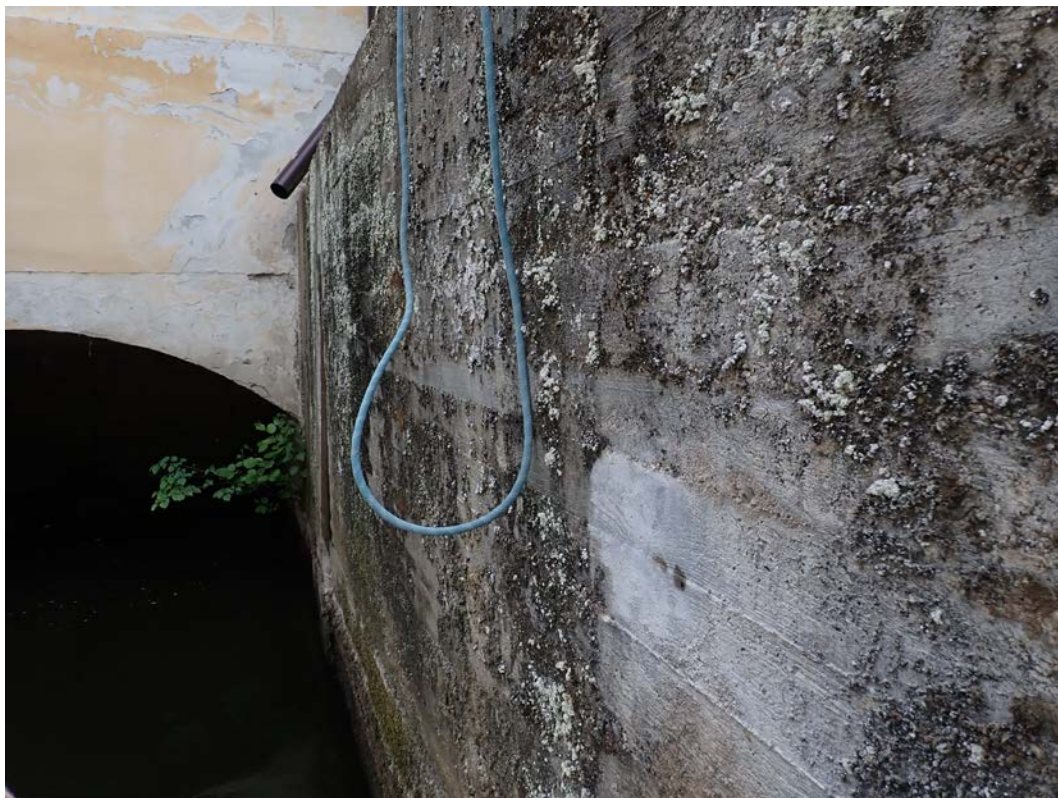
Foto 8: Povrch betonu degradují mechy a lišejníky.
